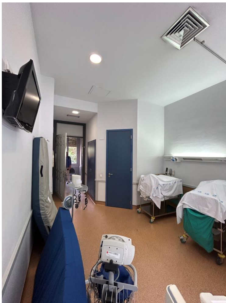
Habitación existente tipo a adecuar, ya reformada entre 1996- 2006: suelo PVC, puerta fenólica, Techo liso, paredes texturglass.
